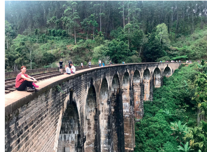
GIORNO 14. Tutti sanno che è proprio camminando lungo i binari che si può arrivare a questo ponte, davvero suggestivo e pittoresco, che emerge sospeso sugli archi in mezzo alla foresta.
